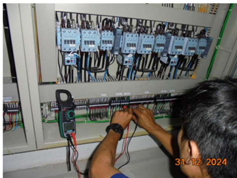
เจ้าหน้าที่ตรวจสอบการทำงานของระบบระบายน้ำ
