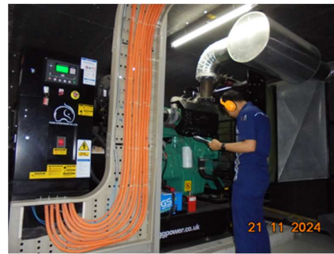
เจ้าหน้าที่ทำการตรวจสอบเครื่องกำเนิดไฟฟ้าสำรอง
